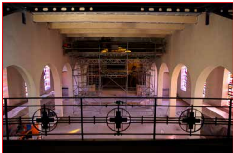
Renovierung der Pfarrkirche / Rénovation de l'église paroissiale, Lorentzweiler
