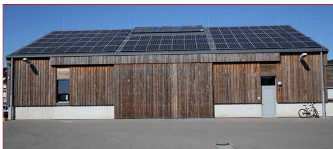
Lagerhalle für die lokalen Vereine, PV-Anlage mit Bürgerbeteiligung / Hall de stockage pour les associations locales, installation PV avec participation des citoyens
