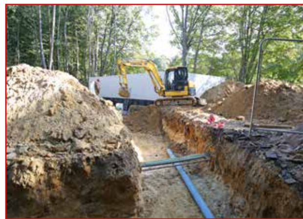
Bau eines neuen Trinkwasser-behälters / Construction d'un nouveau réservoir d'eau potable, Blaschette
