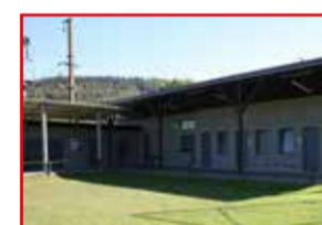
Renovierung der Umkleieräume auf dem Fußballfeld / Rénovation des vestiaires du club de football, Lorentzweiler
