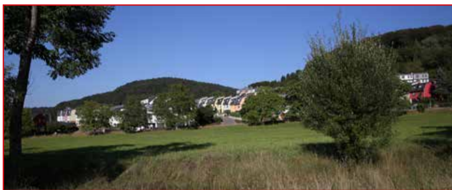
Neugestaltung der « Cité Roger Schmitz » und Erdgasverlegung / Réaménagement de la « Cité Roger Schmitz » avec pose de gaz naturel, Bofferdange
