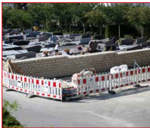
Erneuerung der Friedhofmauer / Réaménagement du mur de cimetière, Lorentzweiler
