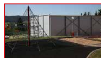
Pilotprojekt « Provisorische Sporthalle » / Projet Pilote, hall des sports provisoire, Lorentzweiler
