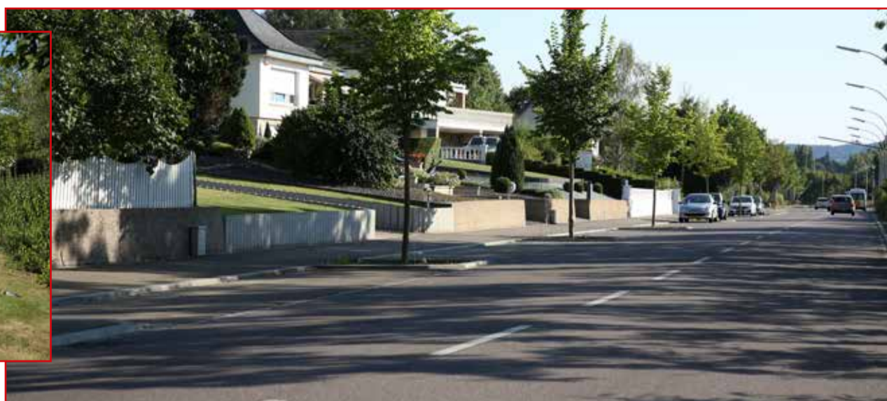
Neugestaltung der N7 / Réaménagement de la N7, Bofferdange
