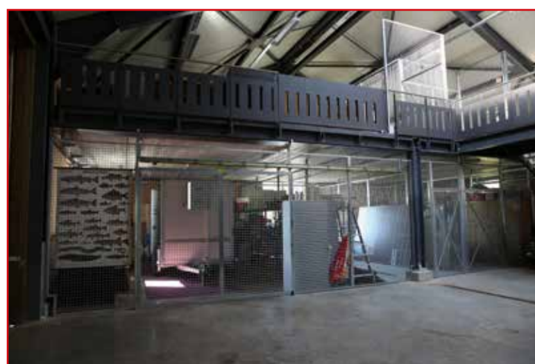
Innenansicht der Halle / Vue de l'intérieur du hall
